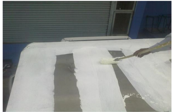
APLICACIÓN DE LA PRIMERA CAPA DE THERMOFORZZA R
