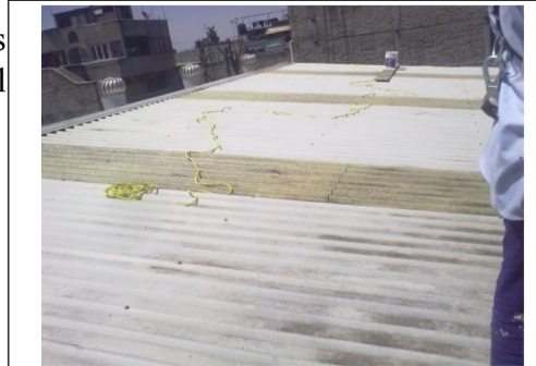
ANTES DE LA APLICACIÓN DE THERMOFORZZA R
