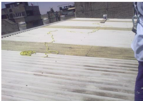
ANTES DE LA APLICACIÓN DE THERMOFORZZA R
