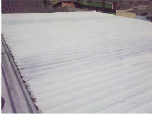
PRIMERA MANO DEL RECUBRIMIENTO THERMOFORZZA R
