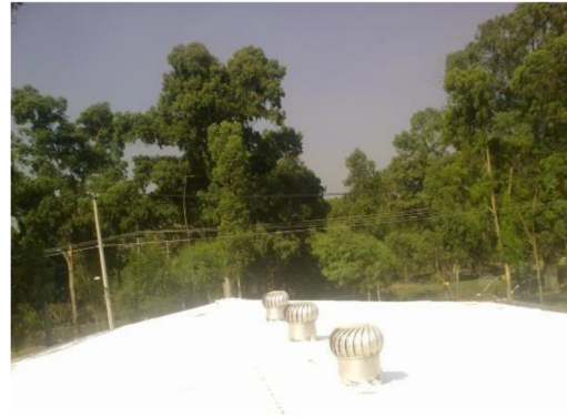
UNA VEZ APLICADO EL RECUBRIMIENTO TÉRMICO THERMOFORZZA R
